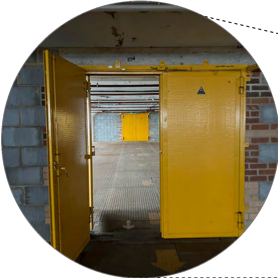
EXISTING STEEL DOOR
